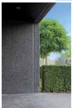
Oppervlak na ontkisting uitgewassen en afgewerkt in de fabriek - arch. Group O - De Brabandere Architecten - © A. Nullens
