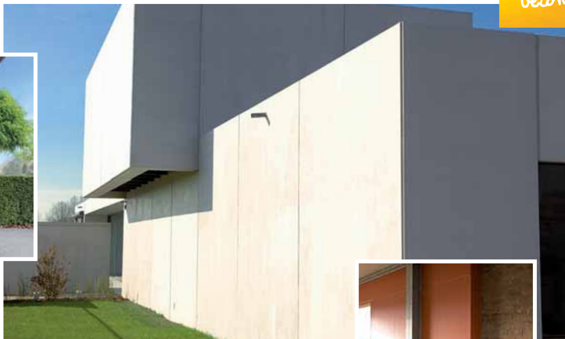
Woning in een abstract volumespel, integraal gebouwd met prefab betonpanelen. arch. L. Binst / Crepain Binst Architecture nv - © Crepain Binst Architecture nv
