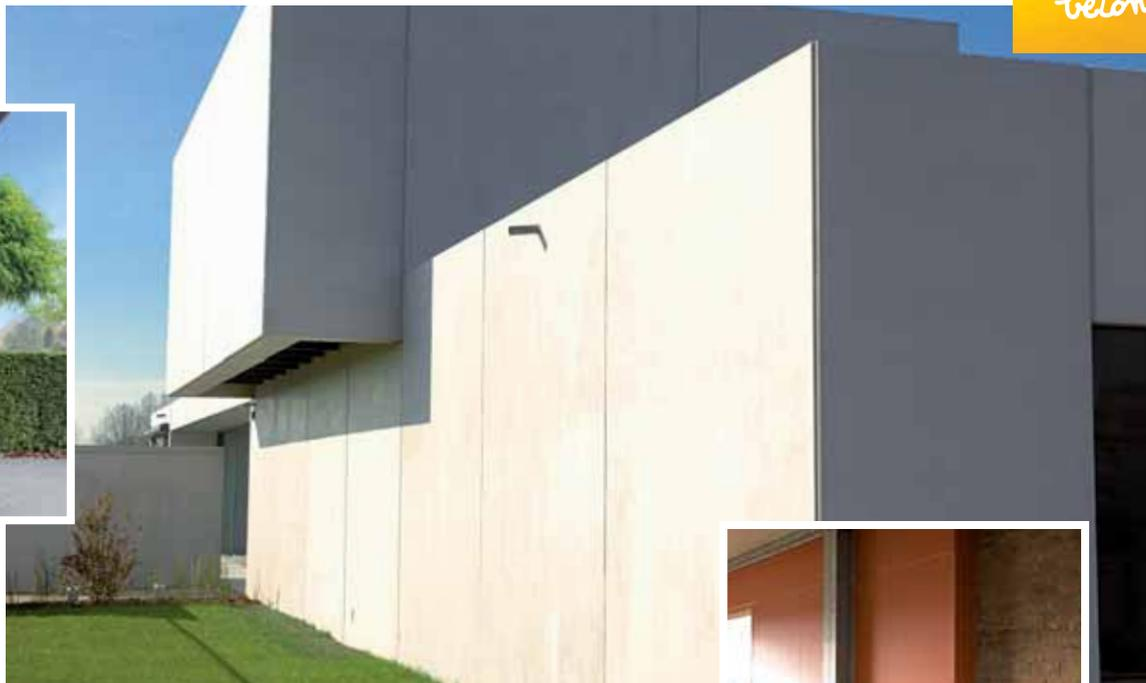
Maison à volumétrie abstraite et uniforme réalisée entièrement en panneaux préfabriqués
